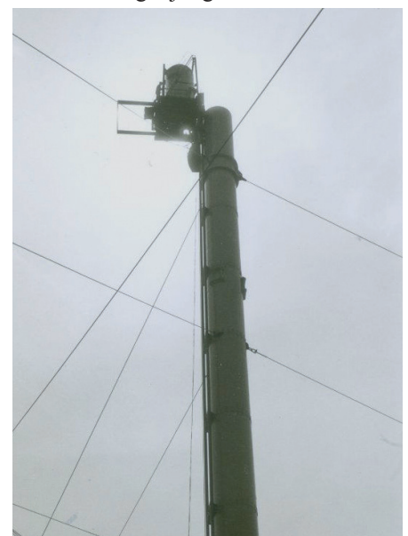
Figuur 2. Het plaatsen van een segment tijdens de bouw in juni 1970.
